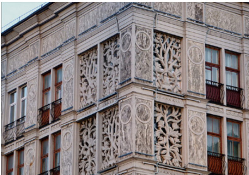
Андрей Буров. «Ажурный дом» в Москве. 1939—40. Один из первых и самых интересных экспериментов в области типового блочного строительства в СССР
